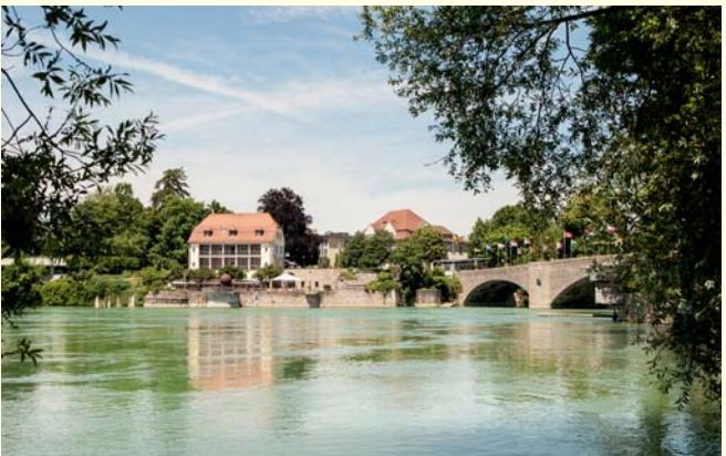
Haus Salmegg und die Rheinbrücke bei Rheinfelden
