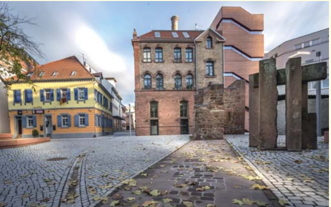
Das neue Lahrer Stadtmuseum in der ehemaligen Tonofenfabrik
