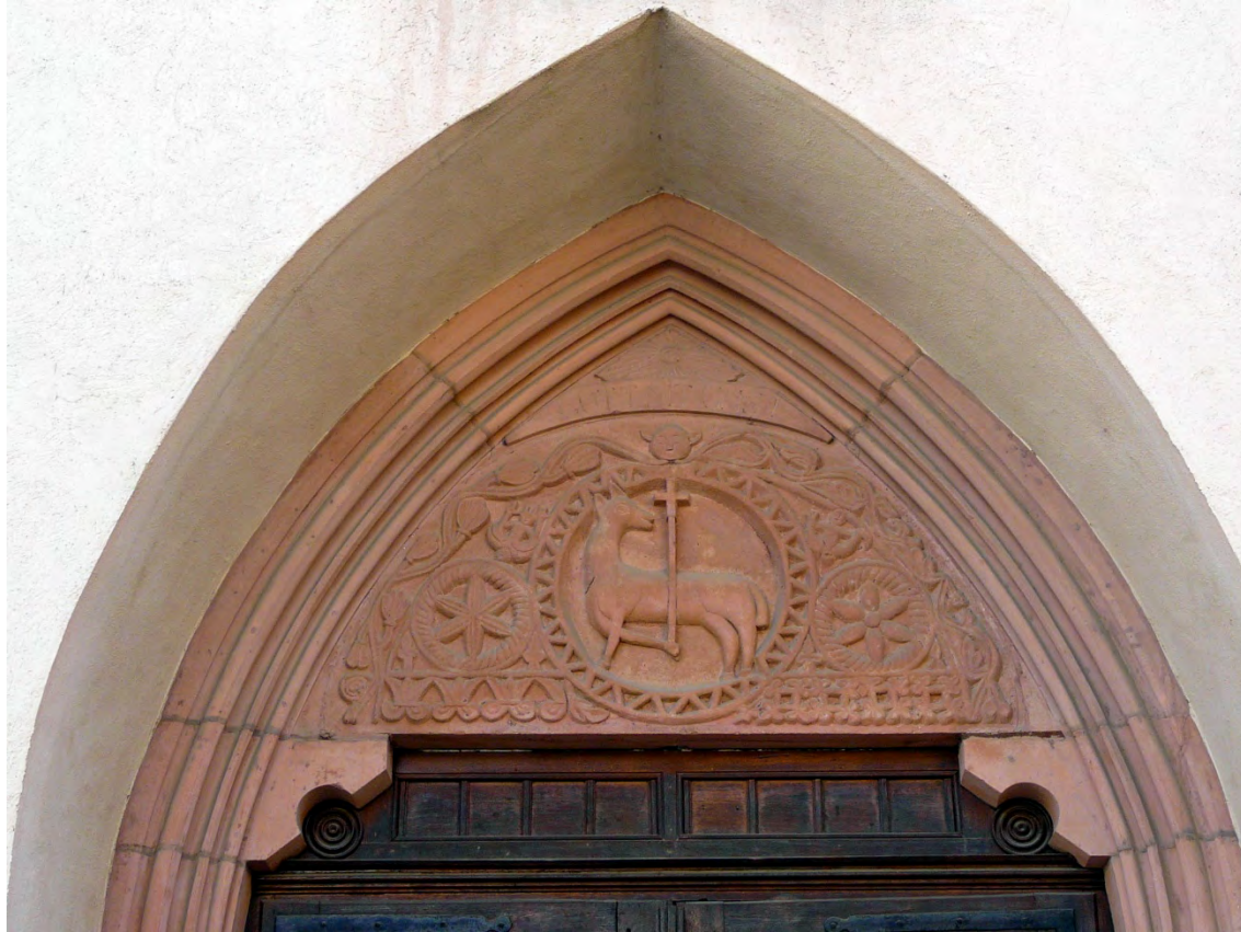
Romanisches Tympanon (KD 53) "Lamm Relief" aus Sandstein, im Eingangsportal an der Westseite der Martinskirche (Original Tympanon steht im Heimatmuseum in Endingen)
